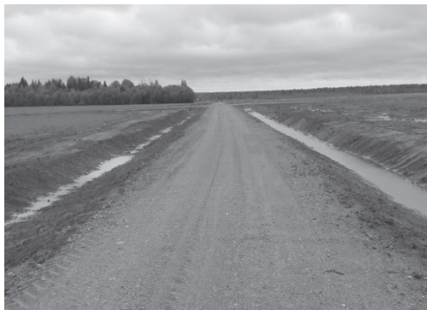
На фото: автодорога до д. Долгоруково после ремонтных работ.
